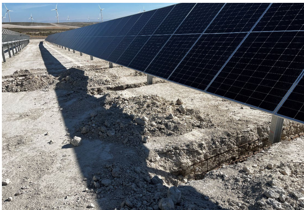
Figura 41 Cimentación de las hincas rechazadas
