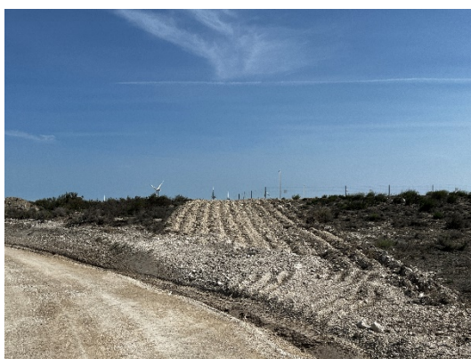
Figura 15 Restauración de accesos temporales
