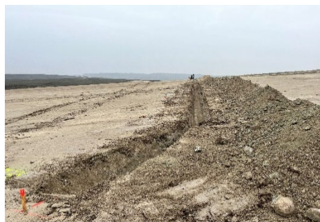
Figura 3 Apertura de zanjas
