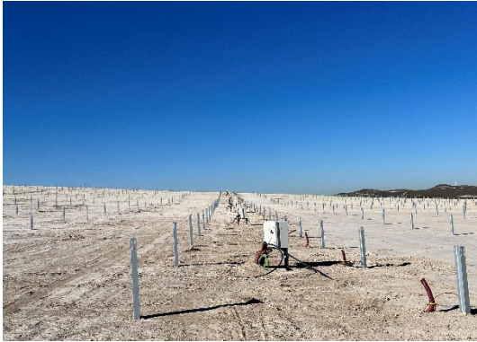
Figura 11 Montaje de los cuadros de control
