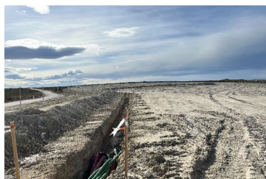
Figura 10 Tendido de cable de media tensión
