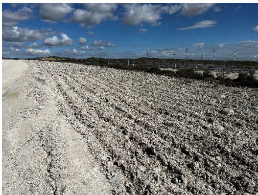
Figura 17 Descompactación del suelo
