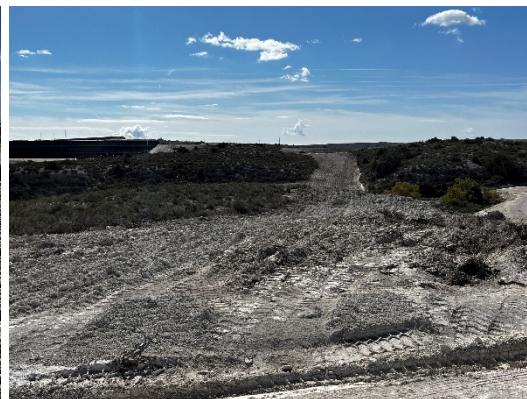
Figura 18 Descompactación del suelo
