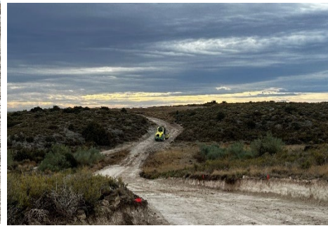
Figura 5 Apertura de viales
