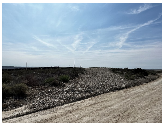
Figura 16 Restauración de accesos temporales
