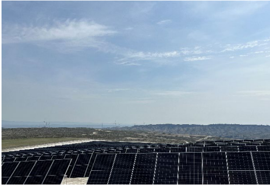
Figura 8 Montaje de los módulos fotovoltaicos
