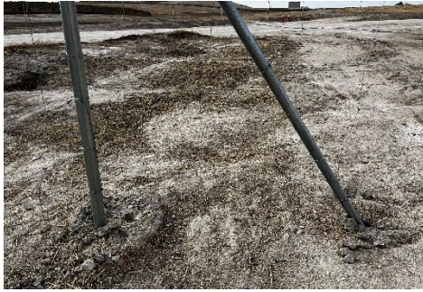
Figura 4 Trabajos de cimentación
