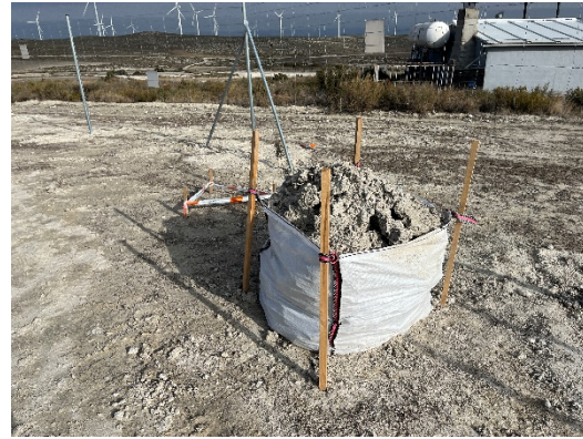
Figura 24 Retirada de los vertidos de hormigón
