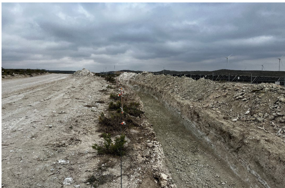
Figura 38 Zanja para la media tensión
