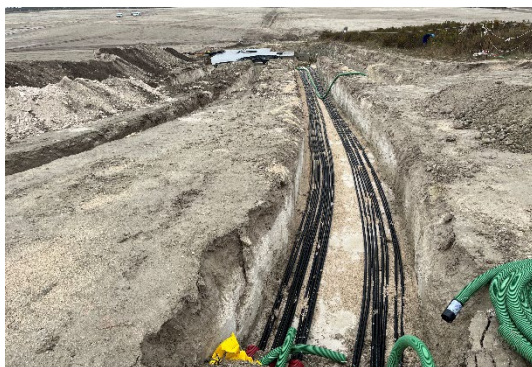
Figura 9 Tendido de cable de baja tensión
